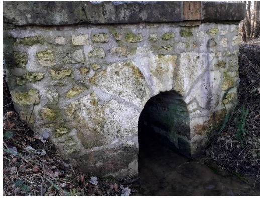
Route de la Bouverie
